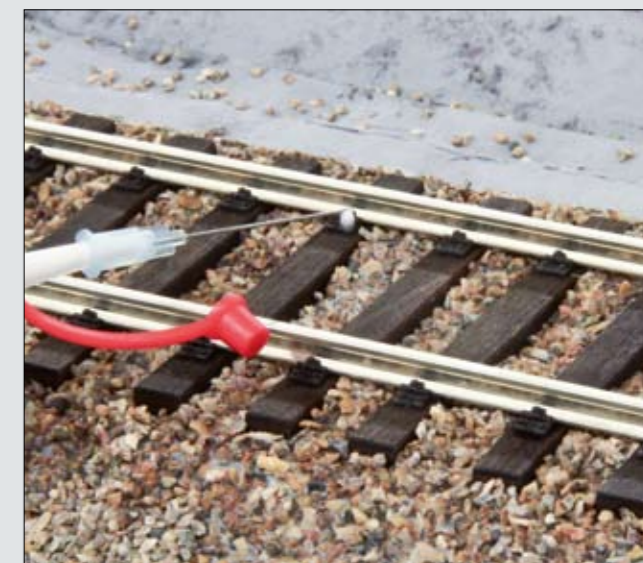
Zwischen den Schwellen wird der Schotterkleber durch Aufsetzen einer Kanüle auf die Applikatortülle noch feiner dosiert
