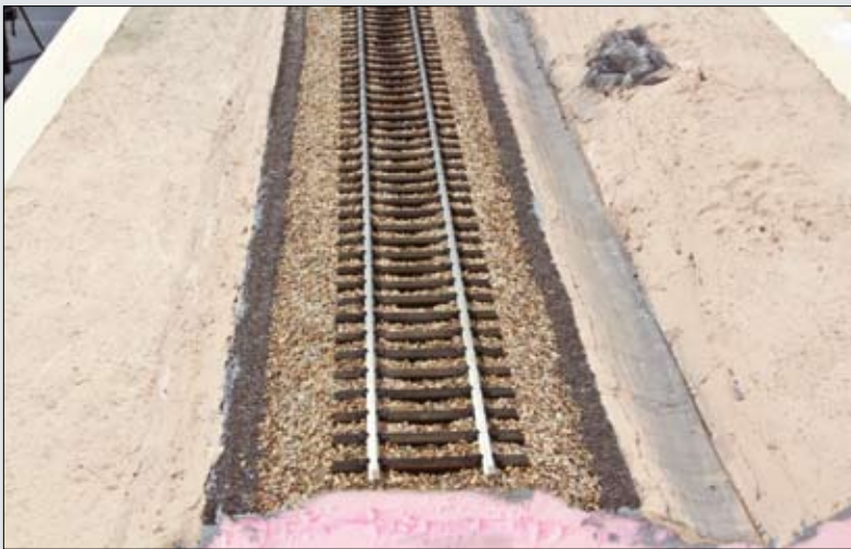
Bis auf die Patinierung des Gleises ist der Oberbau fertig gestellt, das Gelände hat seine Grundfarbe erhalten, der Seitengraben ist dunkel abgesetzt
